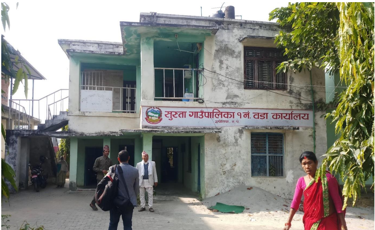
१ नं. वडा कार्यालय भवन, रुपौलिया
